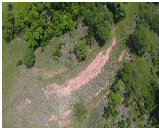
Figura 10 - Área à jusante do barramento (área ampliada do canteiro) em novembro/2021.
