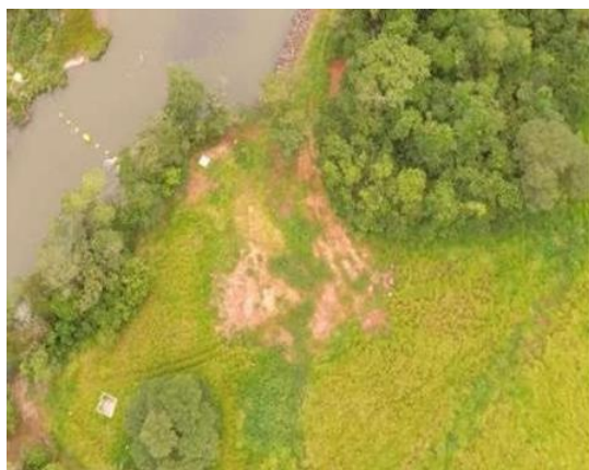
Figura 7 - Área da Captação de água à jusante do barramento (MD). em maio/2021.
