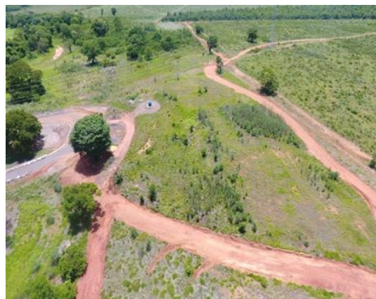
Figura 16 - Área anteriormente ocupada por: Armação, Central de Carpintaria, Almojarifado Civil e Eletrotécnica - Novembro de 2021.
