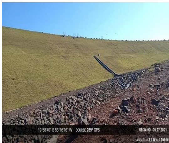
Figura 22 - Área de Acesso provisório à jusante (ME). Maio de 2021.
