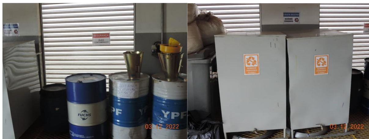
Figura 2. Recipientes para armazenamento de resíduos perigosos. Foto: Cedro
