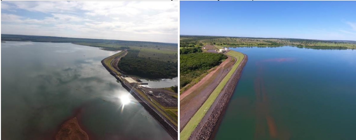
Figura 3. Vista aérea da PCH Verde 4, compondo as áreas de amostragem do reservatório e a jusante do barramento, incluindo a casa de força e subestação. Campanhas de 2022.
