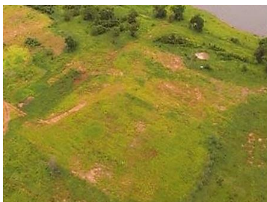
Figura 3 - Áreas do anteriormente ocupadas pela Central de Concreto, Laboratório de Concreto e Solo e Pré-montagem em maio/2021.
