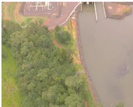
Figura 19 - Área próxima à casa de força e subestação. Maio de 2021.
