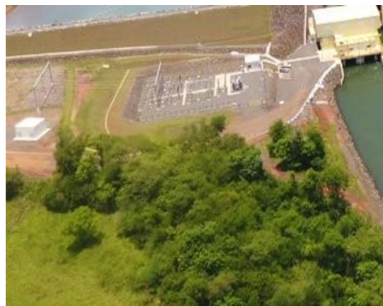
Figura 20 - Área próxima à casa de força e subestação. Novembro de 2021.
