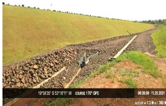
Figura 23 - Área de Acesso provisório à jusante (ME). Novembro de 2021.
