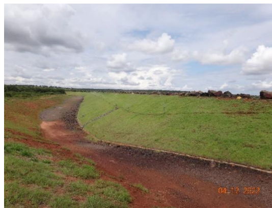
Figura 26 - Vista dos taludes, em novembro/2022.
