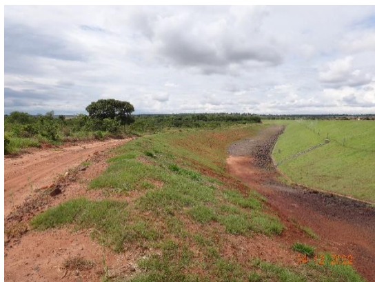
Figura 25 - Vista dos taludes, em novembro/2022.
